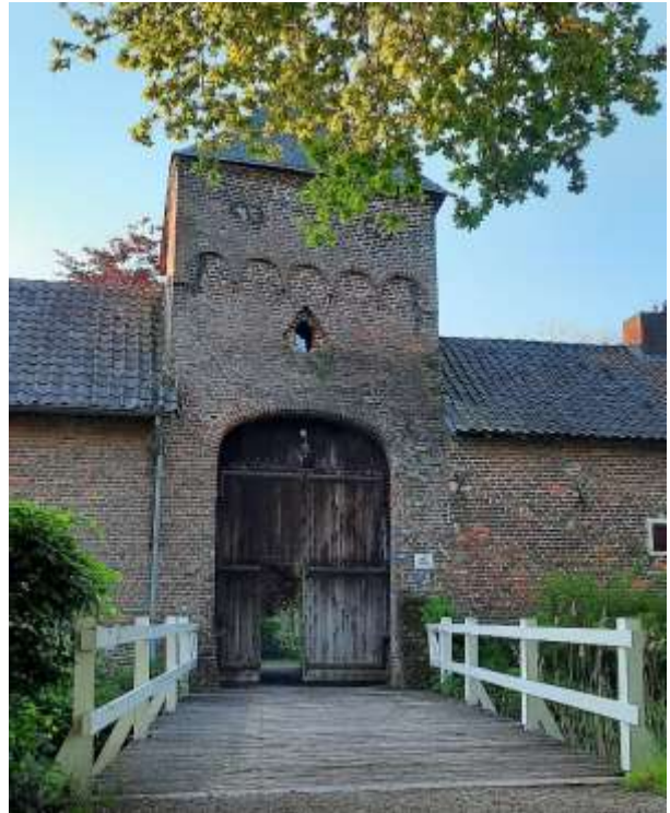
Foto: Leuning van de toegangsbrug zijn hersteld
